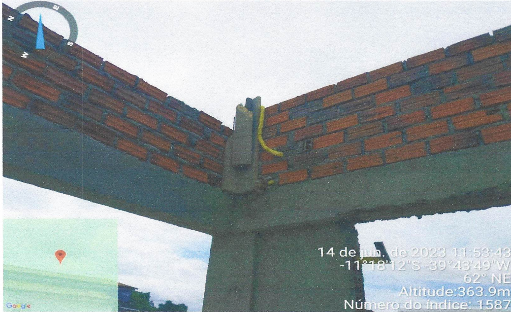
Foto 17 – ALVENARIA DE VEDAÇÃO DE BLOCOS CERÂMICOS FURADOS NA HORIZONTAL DE 9X19X29 CM (ESPESSURA 9 CM) E ARGAMASSA DE ASSENTAMENTO COM PREPARO EM BETONEIRA. AF_12/2021
