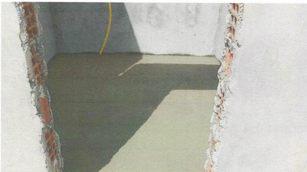
Foto 14 - CONTRAPISO EM ARGAMASSA TRAÇO 1:4 (CIMENTO E AREIA), PREPARO MANUAL, APLICADO EM ÁREAS SECAS SOBRE LAJE, ADERIDO, ACABAMENTO NÃO REFORÇADO, ESPESSURA 2CM. AF_07/2021
