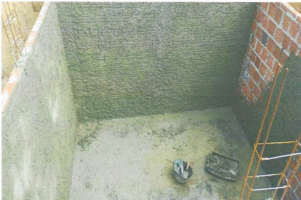
Foto 28 – CHAPISCO APLICADO EM ALVENARIAS E ESTRUTURAS DE CONCRETO INTERNAS, COM COLHER DE PEDREIRO. ARGAMASSA TRAÇO 1:3 COM PREPARO EM BETONEIRA 400L. AF_06/2014
