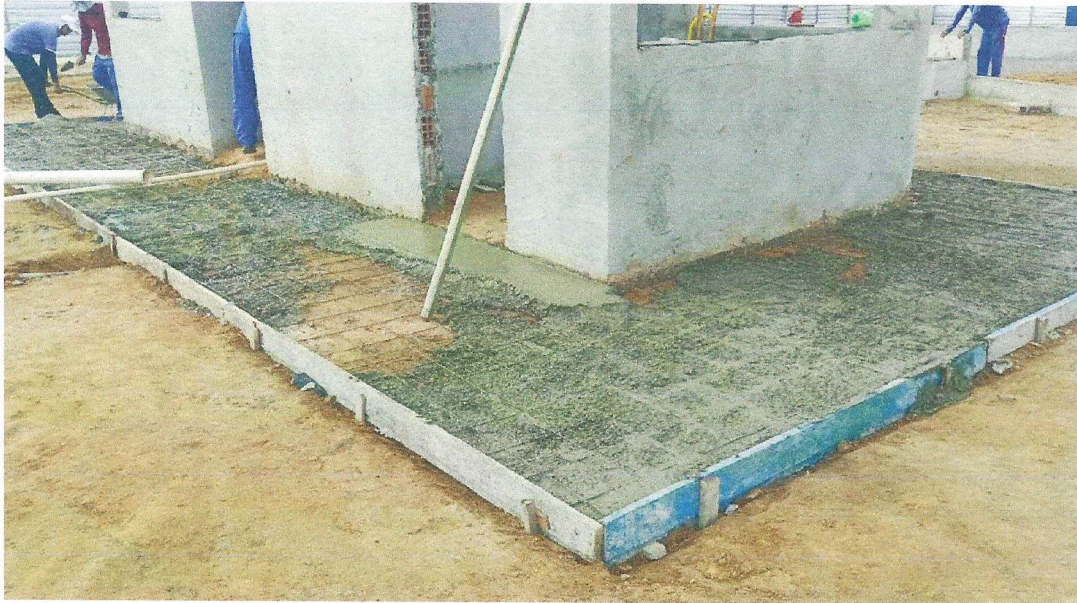
Foto 13 - CONTRAPISO EM ARGAMASSA TRAÇO 1:4 (CIMENTO E AREIA), PREPARO MANUAL, APLICADO EM ÁREAS SECAS SOBRE LAJE, ADERIDO, ACABAMENTO NÃO REFORÇADO, ESPESSURA 2CM. AF_07/2021
