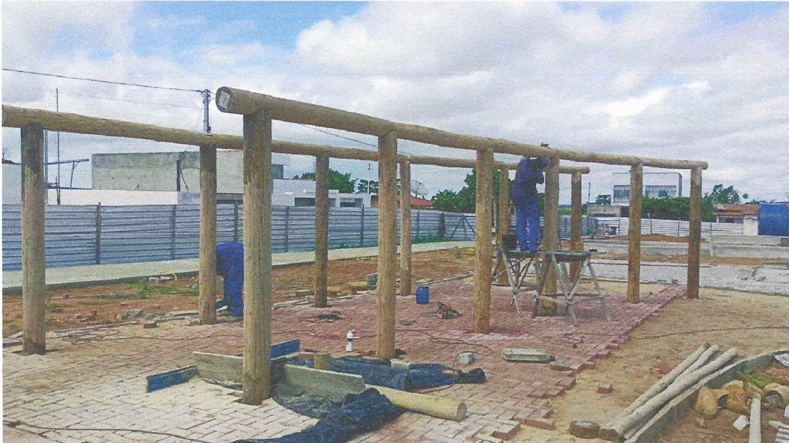
Foto 23 – EXECUÇÃO DE PASSEIO (CALÇADA) OU PISO DE CONCRETO COM CONCRETO MOLDADO IN LOCO, FEITO EM OBRA, ACABAMENTO CONVENCIONAL, ESPESSURA 6 CM, ARMADO. AF_07/2016
