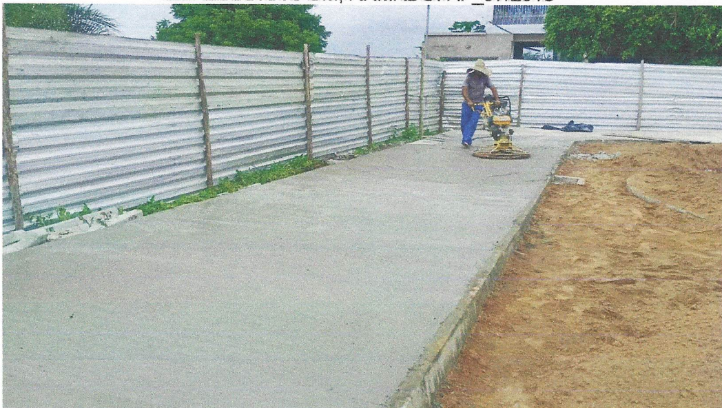
Foto 32– EXECUÇÃO DE PASSEIO (CALÇADA) OU PISO DE CONCRETO COM CONCRETO MOLDADO IN LOCO, FEITO EM OBRA, ACABAMENTO CONVENCIONAL, ESPESSURA 6 CM, ARMADO. AF_07/2016
