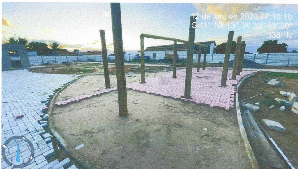
Foto 08 – EXECUÇÃO DE PÁTIO/ESTACIONAMENTO EM PISO INTERTRAVADO, COM BLOCO RETANGULAR COLORIDO DE 20 X 10 CM, ESPESSURA 6 CM. AF_12/2015
