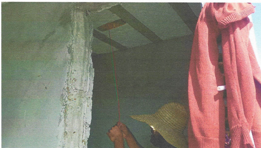
Foto 34 - CABO DE COBRE FLEXÍVEL ISOLADO, 1,5 MM 2 , ANTI-CHAMA 450/750 V, PARA CIRCUITOS TERMINAIS - FORNECIMENTO E INSTALAÇÃO.
