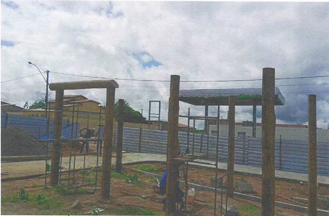
Foto 21 - MASSA ÚNICA, PARA RECEBIMENTO DE PINTURA OU CERÂMICA, ARGAMASSA INDUSTRIALIZADA, PREPARO MECÂNICO, APLICADO COM EQUIPAMENTO DE MISTURA E PROJEÇÃO DE 1,5 M 3 /H EM FACES INTERNAS DE PAREDES, ESPESSURA DE 5MM, SEM EXECUÇÃO DETALISCAS. AF_06/2014
