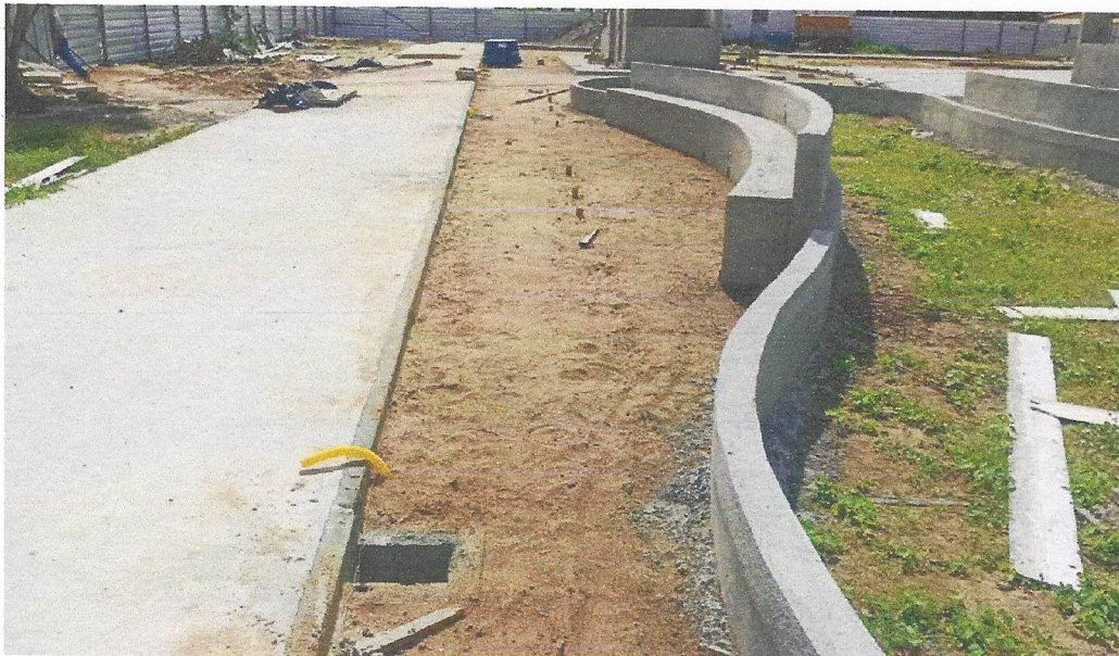
Foto 09 – Caixa de passagem em alvenaria de tijolos maciços esp. = 0,12m, dim. int. = 0,30 x 0,30 x 0,30m
