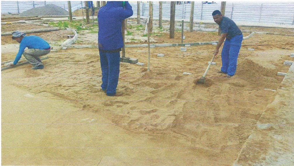
Foto 01 – ATERRO E COMPACTAÇÃO DE COLCHÃO DE AREIA PARA ASSENTAMENTO DE PISO INTERTRAVADO.
