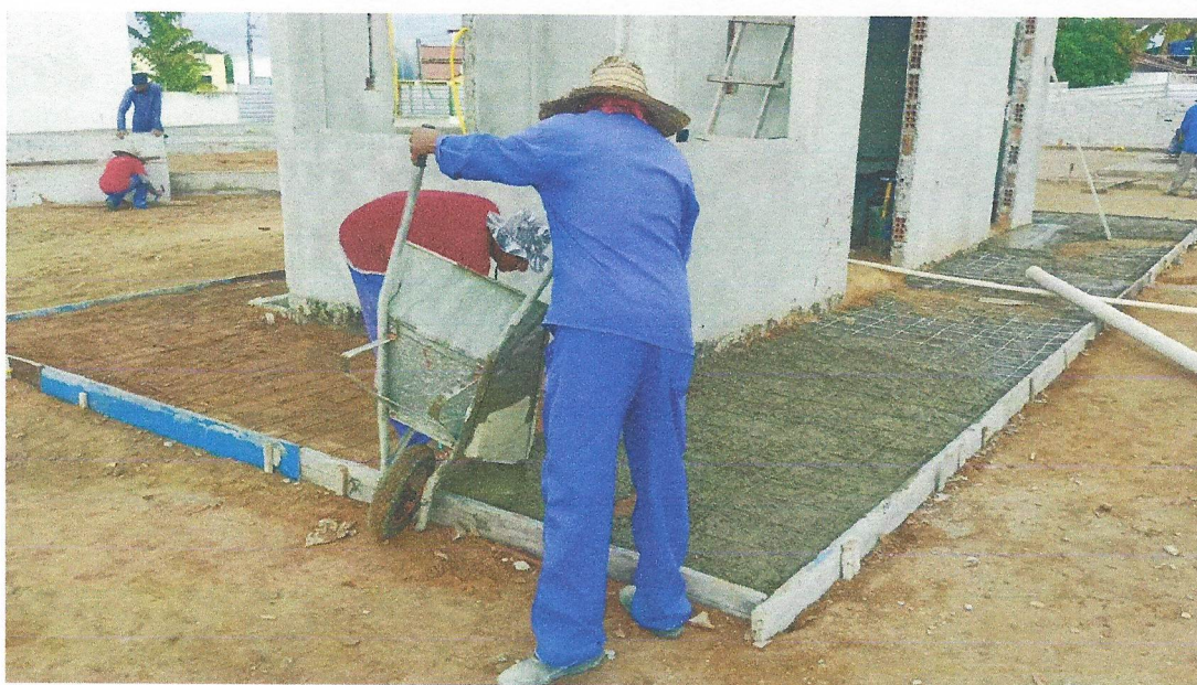
Foto 12 - CONTRAPISO EM ARGAMASSA TRAÇO 1:4 (CIMENTO E AREIA), PREPARO MANUAL, APLICADO EM ÁREAS SECAS SOBRE LAJE, ADERIDO, ACABAMENTO NÃO REFORÇADO, ESPESSURA 2CM.
