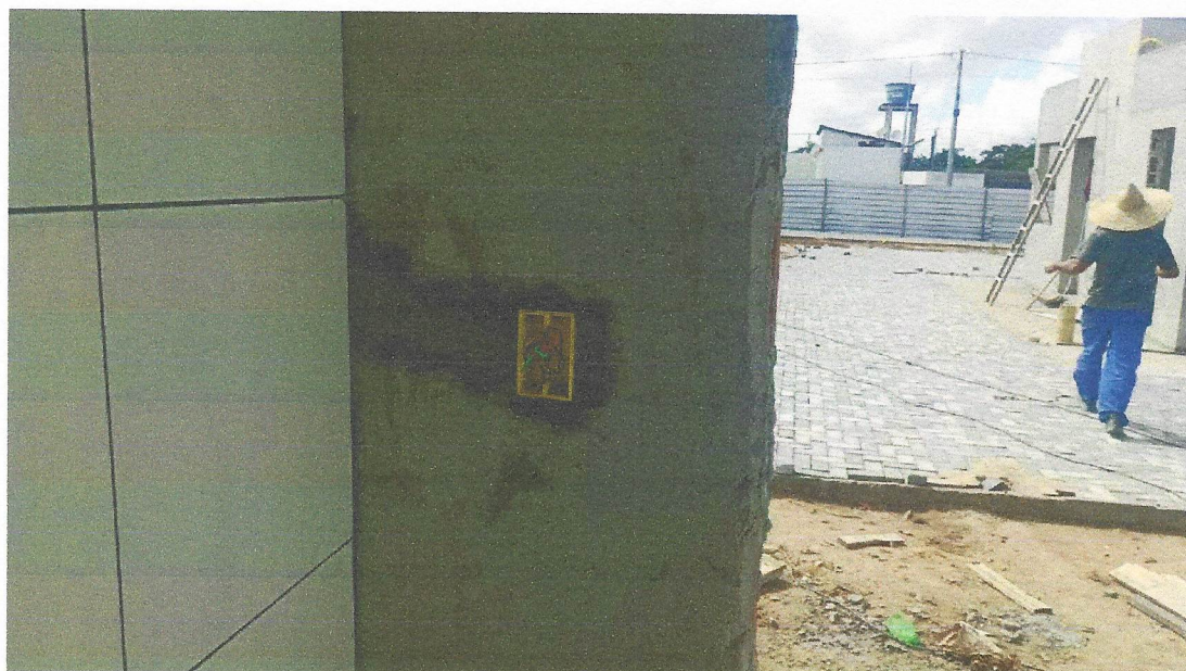
Foto 36 – CABO DE COBRE FLEXÍVEL ISOLADO, 2,5 MM 2 , ANTI-CHAMA 450/750 V, PARA CIRCUITOS TERMINAIS - FORNECIMENTO E INSTALAÇÃO. AF_12/2015
