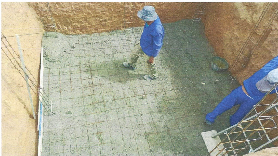
Foto 26 – EXECUÇÃO DE PASSEIO (CALÇADA) OU PISO DE CONCRETO COM CONCRETO MOLDADO IN LOCO, FEITO EM OBRA, ACABAMENTO CONVENCIONAL,
